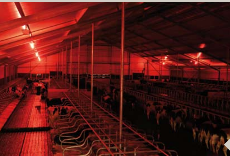
1 og 3 : Metalhaloidlamper 400W (findes også i en 250W-udgave).
